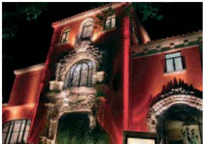
Gevelverlichting Gebruikte producten: 4 x EFFECTlight rood. 2 x OT 06/100-240/24 Totaal vermogen: 6W.
